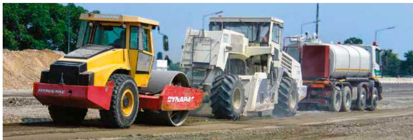
La rigenerazione in situ della sottobase con il metodo del bitume schiumato
