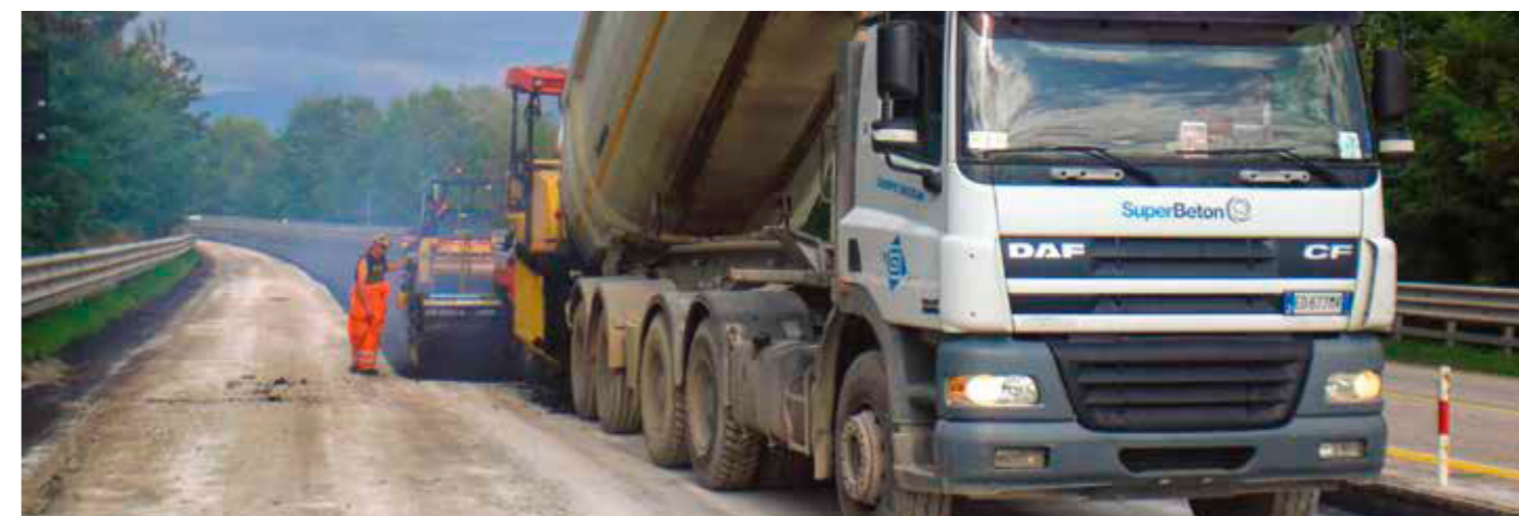
La stesa dei conglomerati bituminosi confezionati con bitume Alto Modulo
